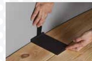
2) Le rebord de 4 mm de la cale FIX PLINTHE® s'utilise comme une cale de serrage de la dernière lame de sol stratifié. Pour cette application, il suffit d'insérer la butée de 4 mm entre la lame et le mur pour effectuer une pression et ainsi serrer le sol stratifié. Il faut ensuite rajouter les cales crantées entre le FIX PLINTHE® et le mur.
