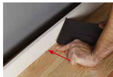
3) En basculant la cale plastique FIX PLINTHE® à 90°, la clé métallique se cale dans l'espace de dilatation entre le mur et le revêtement de sol.
